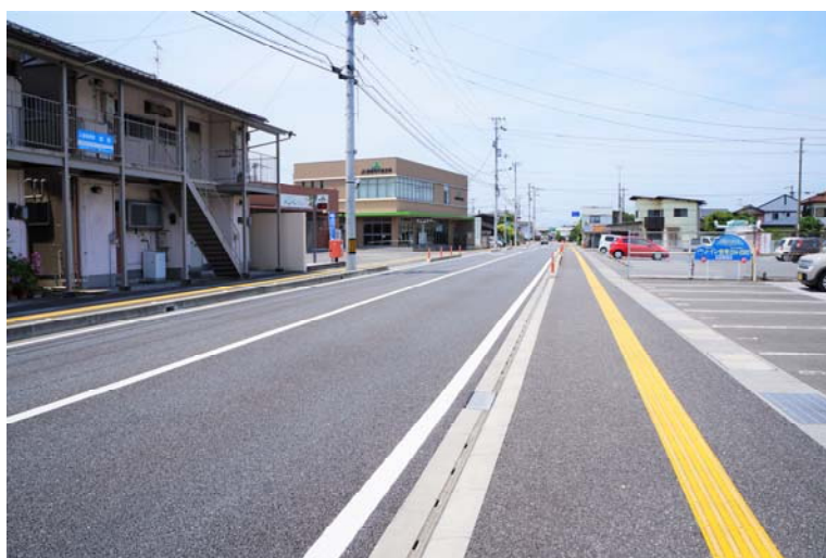
整備が進む県道田村高須線
