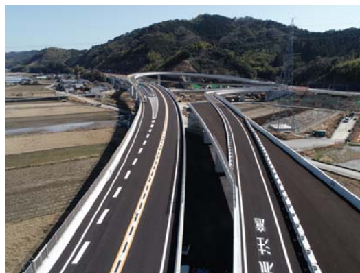
整備が完了した東部自動車道
