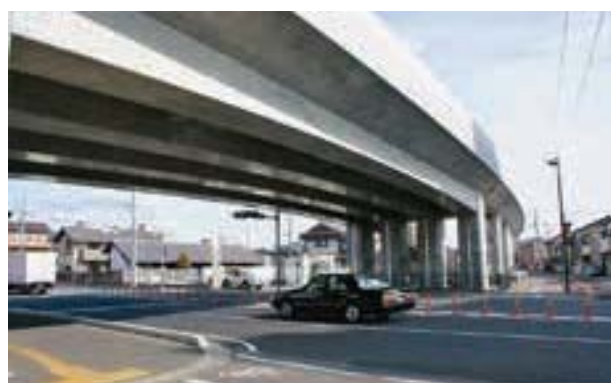
図 JR土讃線連続立体交差事業完了状況
