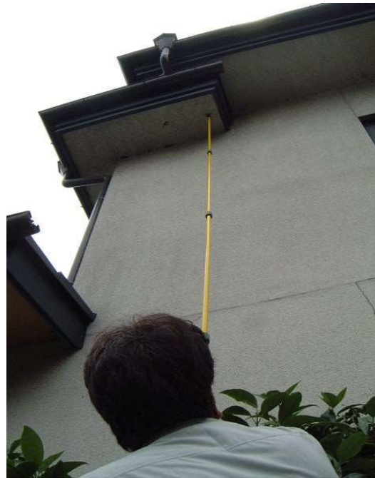
外壁の寸法調査
