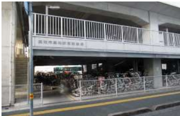
設置場所: 駐輪場南入口上部 縦: 約0.3m 横: 約6m
