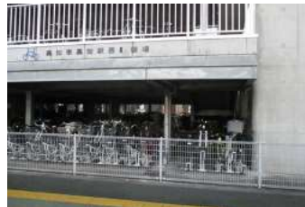
設置場所: 駐輪場北入口上部 縦: 約0.3m 横: 約6m
