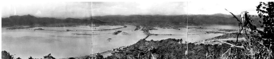
写真 昭和南海地震(M8.0)発災翌日(昭和21年12月22日) [※ 地盤沈下:1.2m~1.3m]
