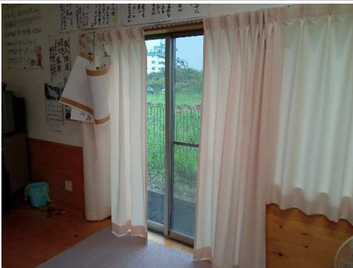
①窓ガラスに割れはないか確認
