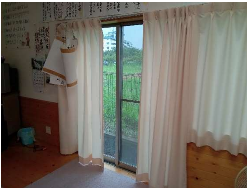
①窓ガラスに割れはないか確認
