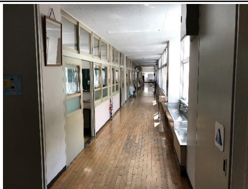
④天井：照明などの落下物がないか確認
