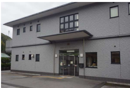
①昇降口：窓ガラスに割れはないか確認
