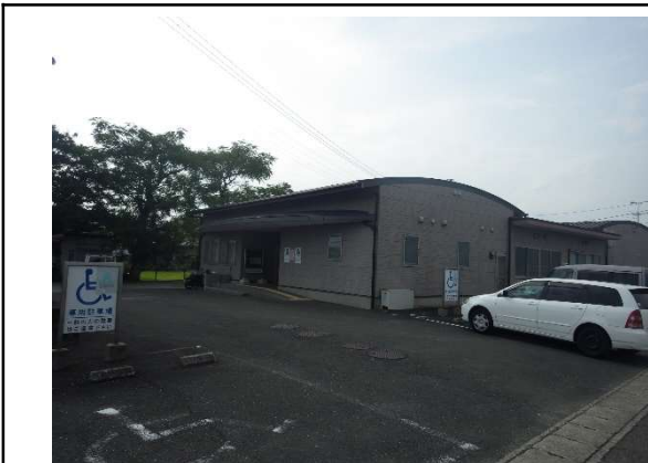
①建物全体に傾きなどがないか
