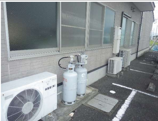
③プロパン保管場所：転倒していないか 漏れていないか
