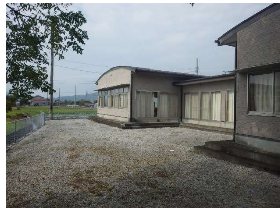
②窓ガラスの割れはないか
