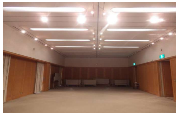
②天井：ガラスの割れや落下などがないか確認
