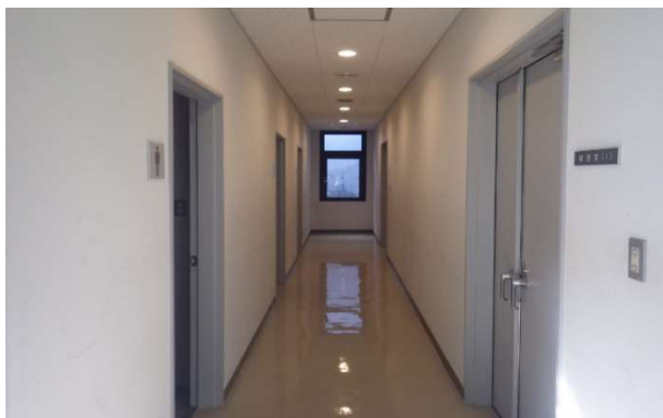
③廊下：天井のズレ、照明の落下はないか
