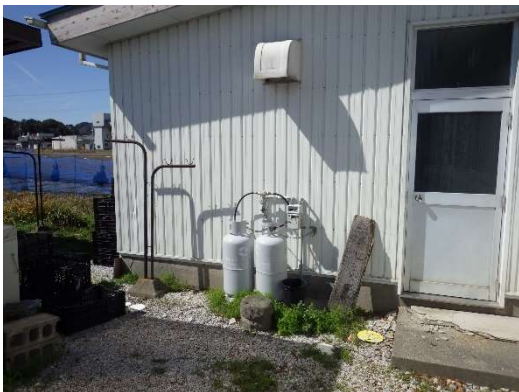
③LPG保管場所：転倒していないか 漏れていないか
