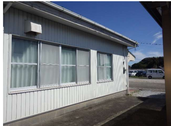
②窓ガラスの割れはないか
