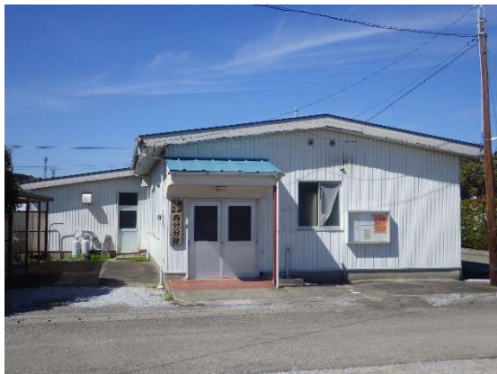
①建物全体に傾きなどがないか
