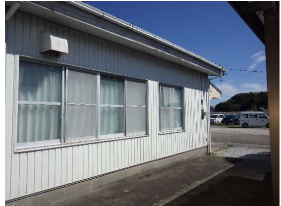
②窓ガラスの割れはないか
