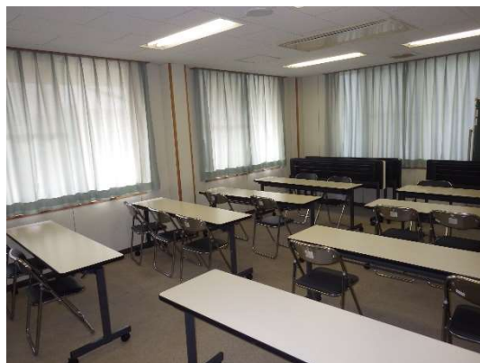
②窓ガラスの割れはないか
