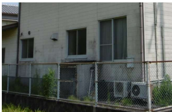
③プロパン保管場所：転倒していないか 漏れていないか
