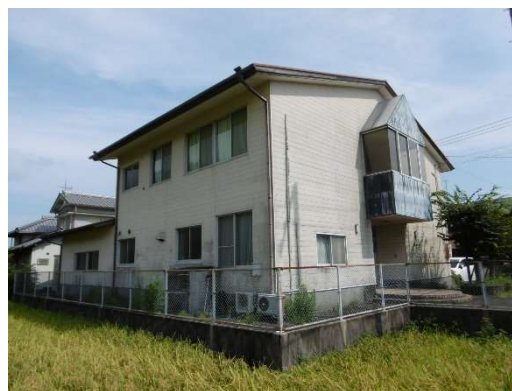
②窓ガラスの割れはないか
