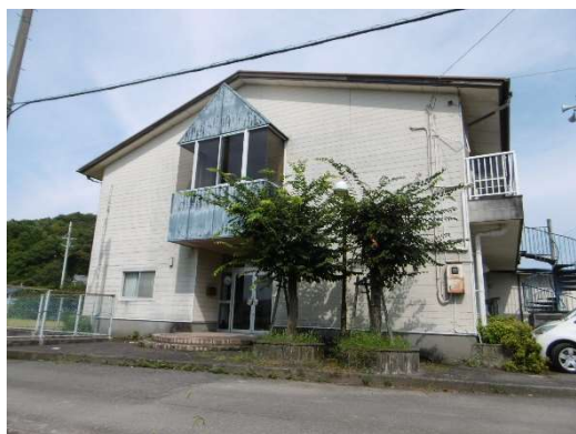
①建物全体に傾きなどがないか
