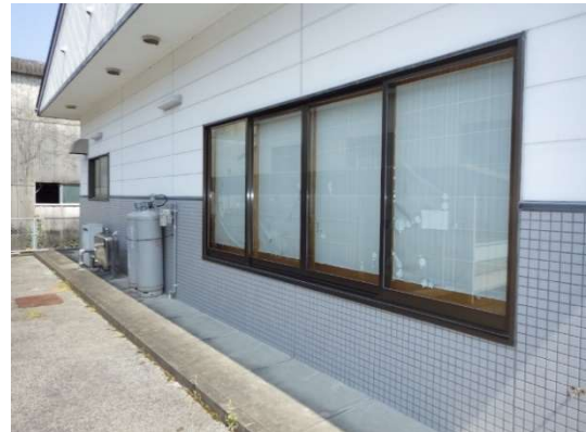
②窓ガラスの割れはないか
