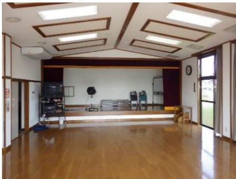
①天井：照明などの落下物がないか確認
