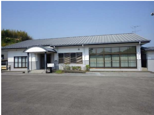
①建物全体に傾きなどがいないか
