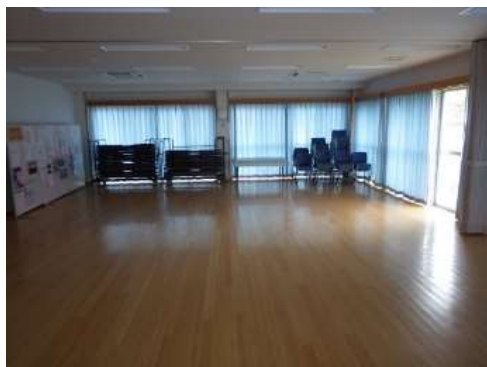
①天井：照明などの落下物がないか確認
