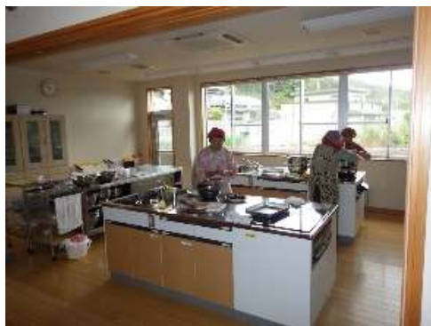
②調理実習室：火災は発生していないか、異臭はしていないか確認
