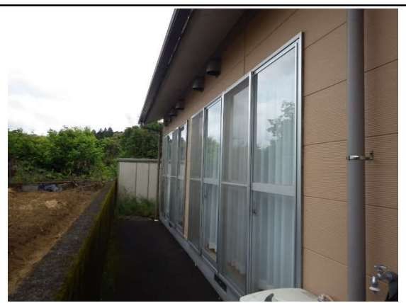
②窓ガラスの割れはないか
