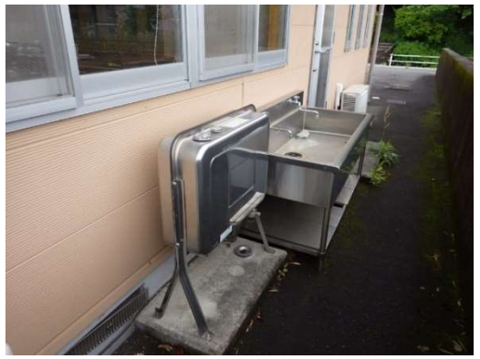
③灯油保管場所：転倒していないか、 漏れていないか
