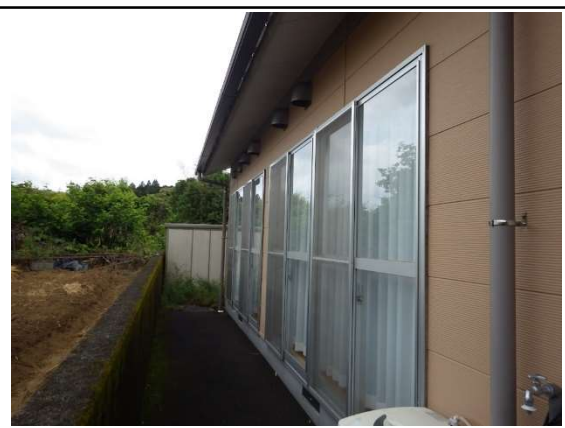
②窓ガラスの割れはないか
