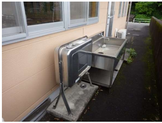
③灯油保管場所：転倒していないか、 漏れていないか
