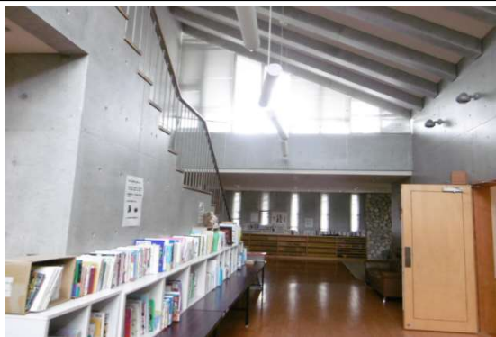
①窓ガラスに割れはないか確認
