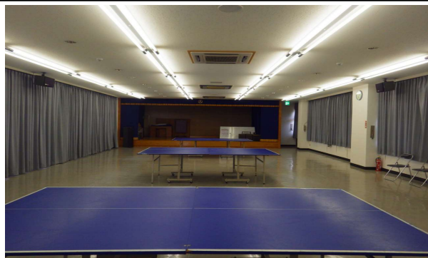
②ホール：大きなひび割れ、崩れ落ちがないか確認
