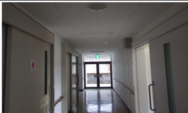
①天井・壁：照明の落下、窓ガラスの落下はないか確認
