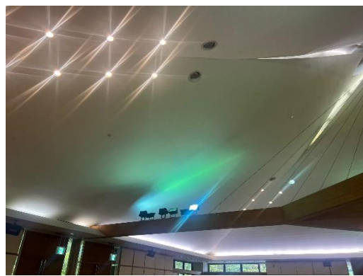
②天井：照明などの落下物がないか確認
