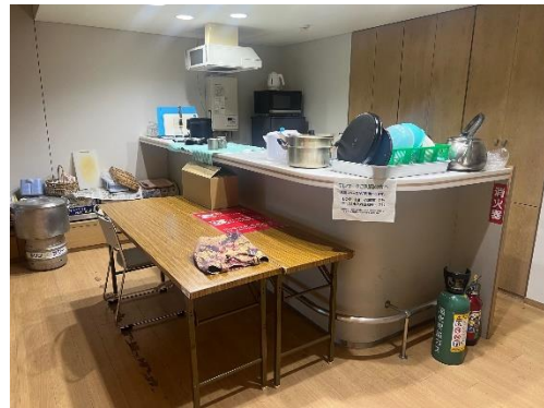
④台所：火災は発生していないか、異臭はしていないか確認
