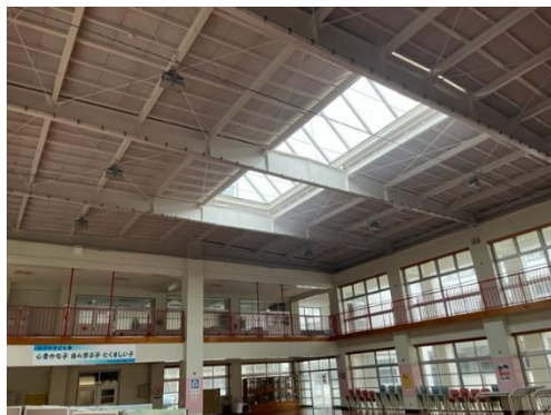
④天井：照明などの落下物がないか確認
