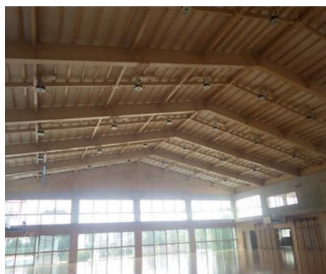
①天井：照明などの落下物がないか確認
