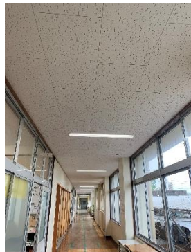
④天井：照明などの落下物がないか確認
