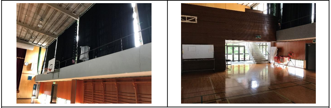
①外壁の落下、窓ガラスの割れはないか確認（施設全体を確認）
