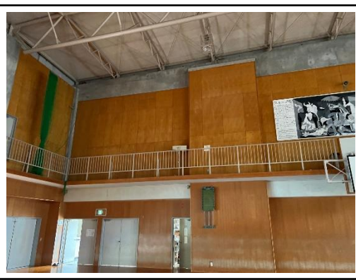
①外壁の落下、窓ガラスの割れはないか確認（施設全体を確認）
