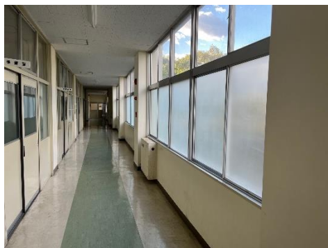
①廊下：窓ガラスに割れはないか確認
