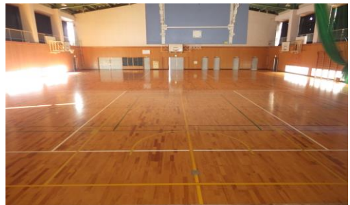
④内壁：大きなひび割れ、崩れ落ちがないか確認
