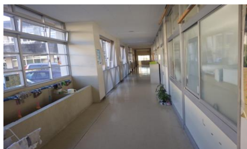
①廊下：窓ガラスに割れはないか、照明などの落下はないか確認
