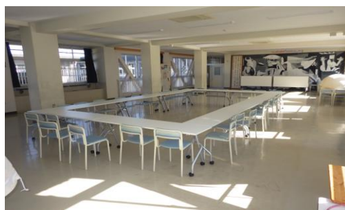
②教室など：照明などの落下物はないか確認
