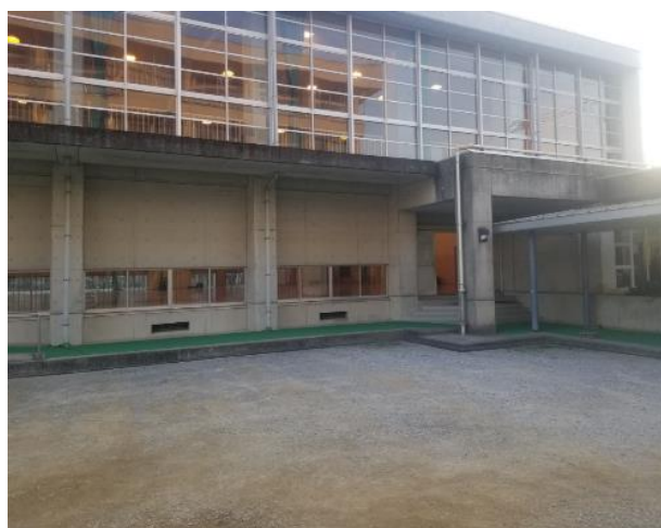
①外壁の落下、窓ガラスの割れはないか
