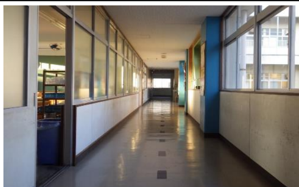
廊下：窓ガラスに割れはないか、照明などの落下はないか確認
