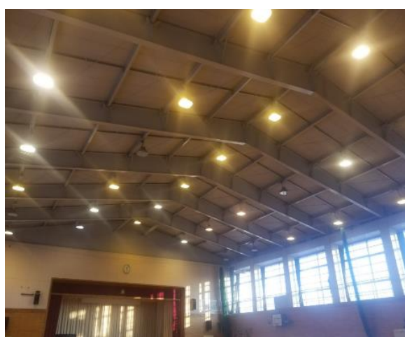
②天井：照明などの落下物がないか確認
