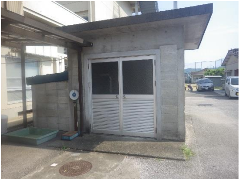
③機械室：感電などの危険があるため近づかない
