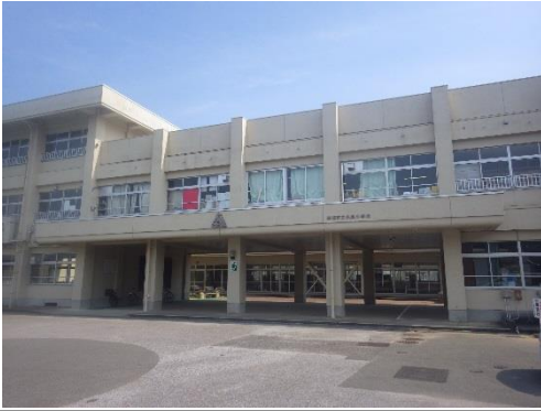
①外壁の落下、窓ガラスの割れはないか （施設全体を確認）
