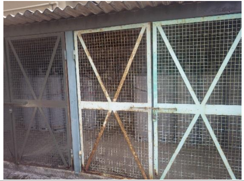
②プロパン置場：転倒していないか ガス臭くないか
