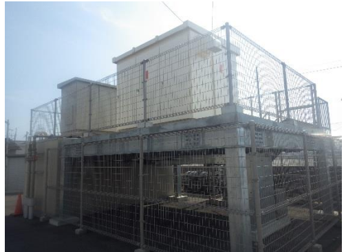
②プロパン置場：転倒していないか ガス臭くないか
