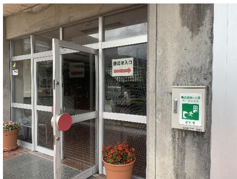
①昇降口：窓ガラスに割れはないか確認
