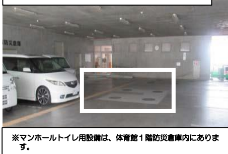
マンホールトイレ設置スペース
