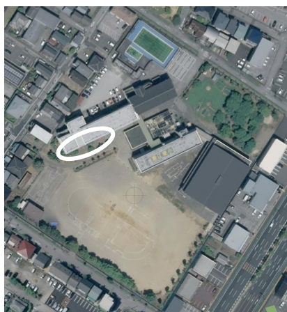
北舎側面入口
