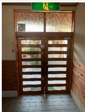
①玄関：窓ガラスに割れはないか確認
