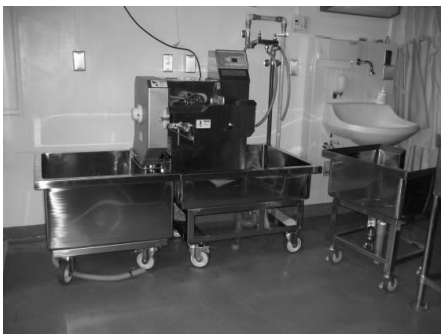
スライサーをドライシンクに設置
