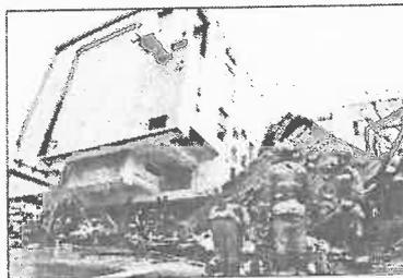
住宅の耐震化が課題。1階が押しつぶされた家屋の倒壊などによる「直接死」が、多数を占めています。
