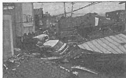
住宅の耐震化が課題。1階が押しつぶされた家屋の倒壊などによる「直接死」が、多数を占めています。
