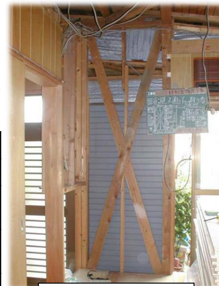
住宅耐震改修の様子
