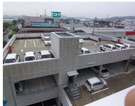
駐車場棟屋上
