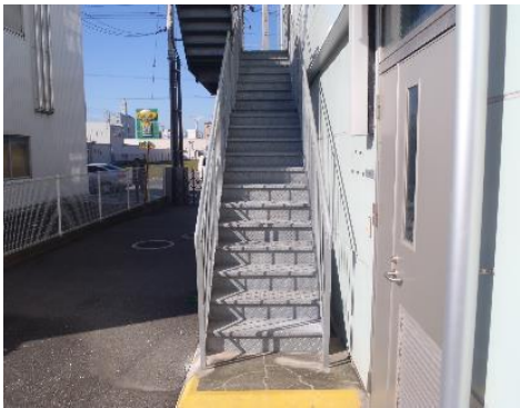
事務所棟外階段
