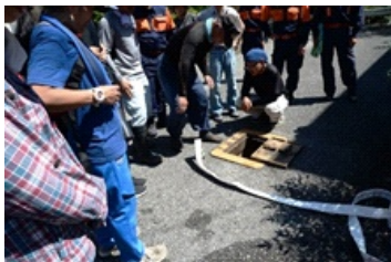
← 消火栓を確認
