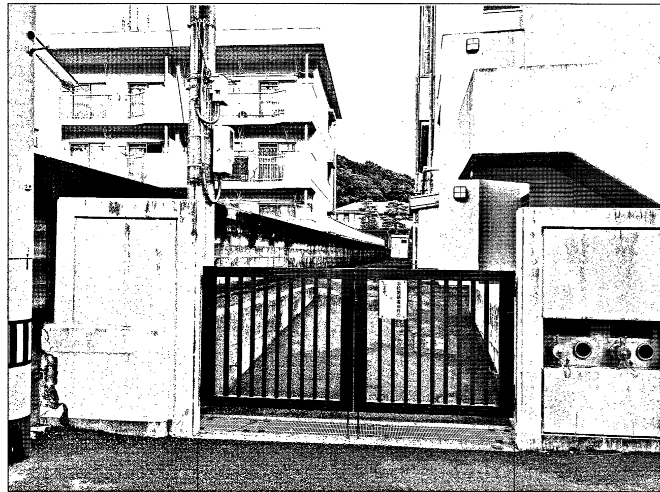
工事車両駐車場入口写真
