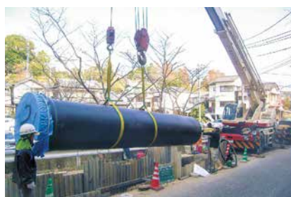
耐震管の埋設
