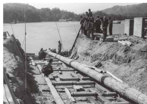
配水管海底布設工事(種崎側から配水管を沈設)
