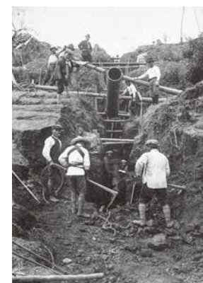
大正13年4月 送水管埋設工事
