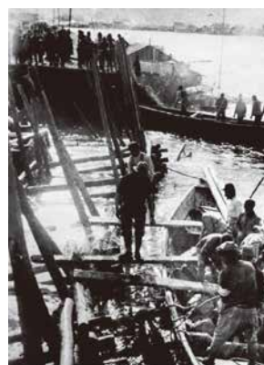
地震で決壊した葛島堤防
