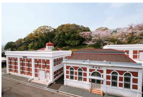
旭浄水場(更新後)
