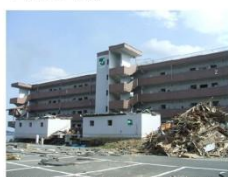
甚大な津波被害があった南三陸町で 町民の命を守った住宅
