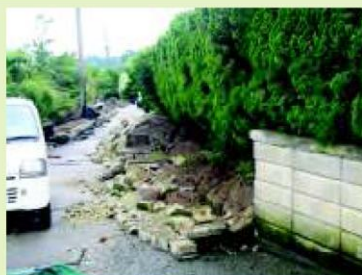
ブロック塀の倒壊による道路閉塞
