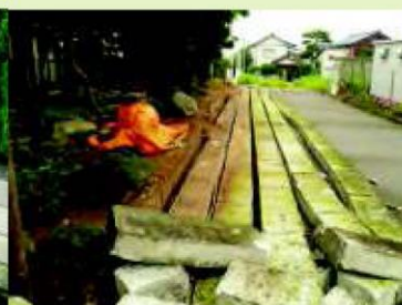
ブロック塀の倒壊による道路閉塞
