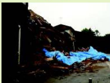
古い家屋の倒壊
