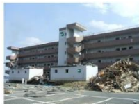
基本的な津波被害があった南三陸町で町民の命を守った住宅
